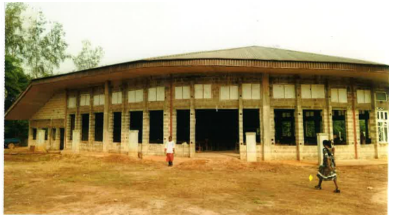
Das Dach ist schon fertig
